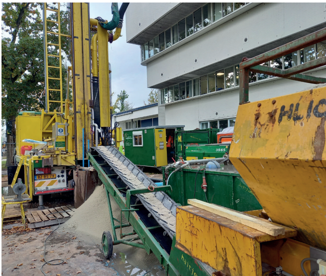
Afb. 7: Het boorgat wordt aangevuld met zand of micoliet afhankelijk van de laag.
