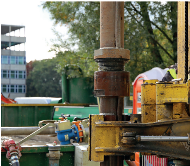
Afb. 3: Boorstangen worden aan elkaar gekoppeld.
