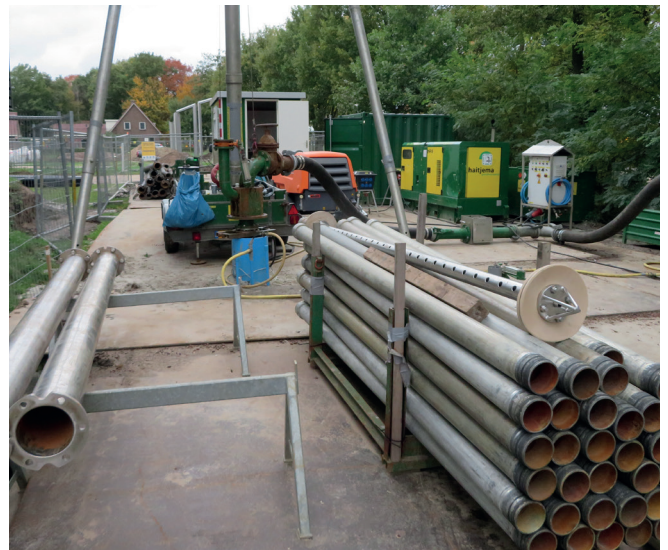
Afb. 8: Opstelling voor het ontwikkelen van de bron, met op de voorgrond het sectieapparaat.
