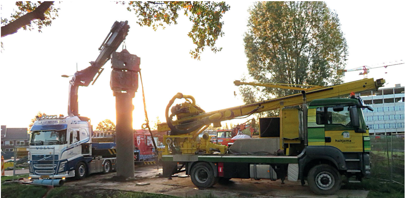
Afb. 1: De mantelbuis wordt ingetrild.
